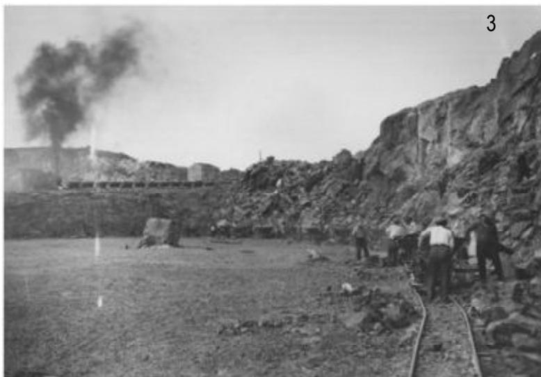
**Ilustración 41 (1, 2 y 3). 1- Antiguo afiche** de propaganda de vagonetas volcables del sistema Decauville de **origen italiano**. Sin otros datos. **2 y 3 - sistema de vías armable** de trocha angosta móvil para vagonetas. **Fuente:** Paz, C. Archivo Digital del GIAAI. (1999-2012).
