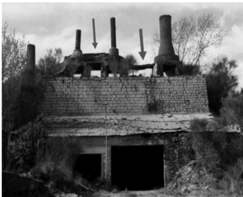
**Ilustración 43. La Calera de Mourño-Yañez** y el sistema de combustión por gases. Las flechas indican las tuberías o conductos, hoy semiderruidos, que unen las cúpulas de los cuatro hornos caleros. Según la explicación de los caleros, este conducto al llenarse de gases calientes, optimizar el proceso de calcinación del Horno. **Fuente:** Paz, C. Archivo digital del GIAAI. (1999-2012).
