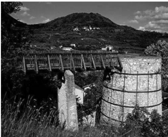
**Ilustración 8.** Hornos de Cava Bomba. Región Véneto. Italia. Funcionamiento: desde la segunda mitad del siglo XVIII y hasta 1970 aproximadamente. Puede observarse: Cilindro del horno, área superior y sistema de transporte tipo puente para vagonetas Decauville
