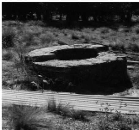
**Ilustración 30.** Antiguo aljibe en Boca Sierra construido con la técnica de la "Martelina"
