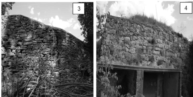
**Ilustración 38 (3 y 4).** El uso de la piedra en la construcción de la casa de Ginocchio y los hornos de Tofoletti. Foto izquierda: parte de la construcción en piedra de la casa de Ginocchio en la cantera de Campagnale. Foto derecha: la construcción en piedra en los hornos de Tofoletti. Sierras Bayas. **Fuente:** Paz, C. Archivo digital del GIAAI (1999-2012).
